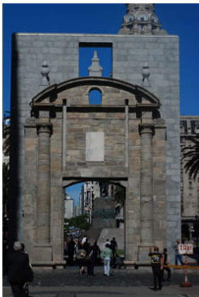
Vista actual reconstruida
